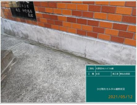
大野田YKハイツA棟 西面基礎ひび割れ補修 作業中
