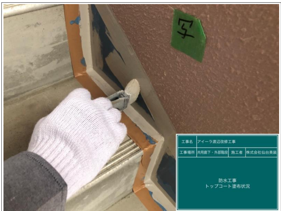
工事名 アイーラ渡辺改修工事 工事場所 共用廊下・外部階段 施工者 株式会社仙台美装 防水工事 トップコート塗布状況
