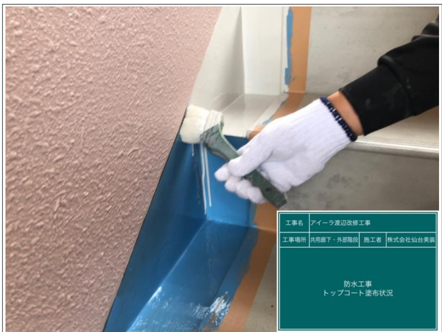
工事名 アイーラ渡辺改修工事 工事場所 共用廊下・外部階段 施工者 株式会社仙台美装 防水工事 トップコート塗布状況
