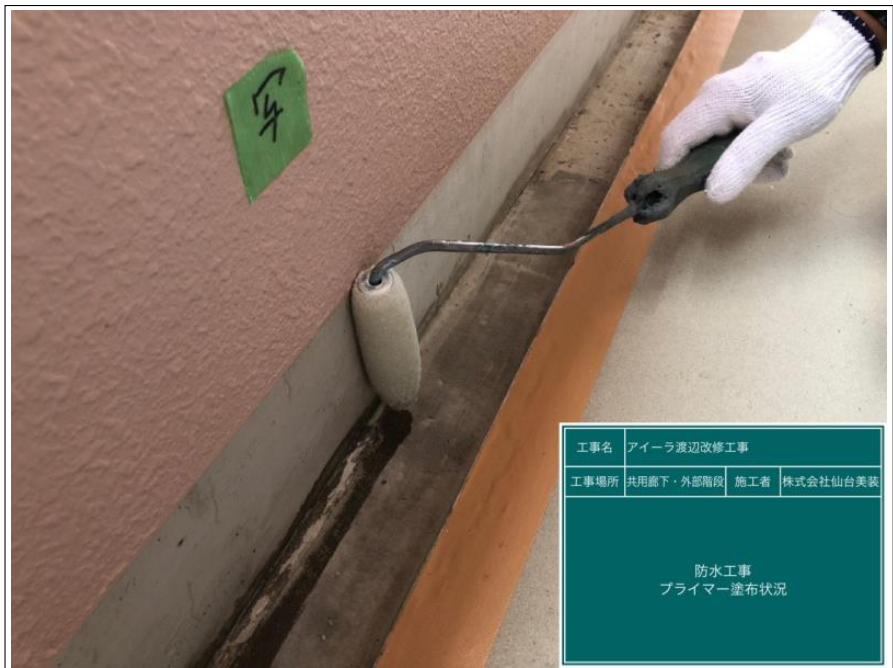
工事名 アイーラ渡辺改修工事 工事場所 共用廊下・外部階段 施工者 株式会社仙台美装 防水工事 プライマー塗布状況
