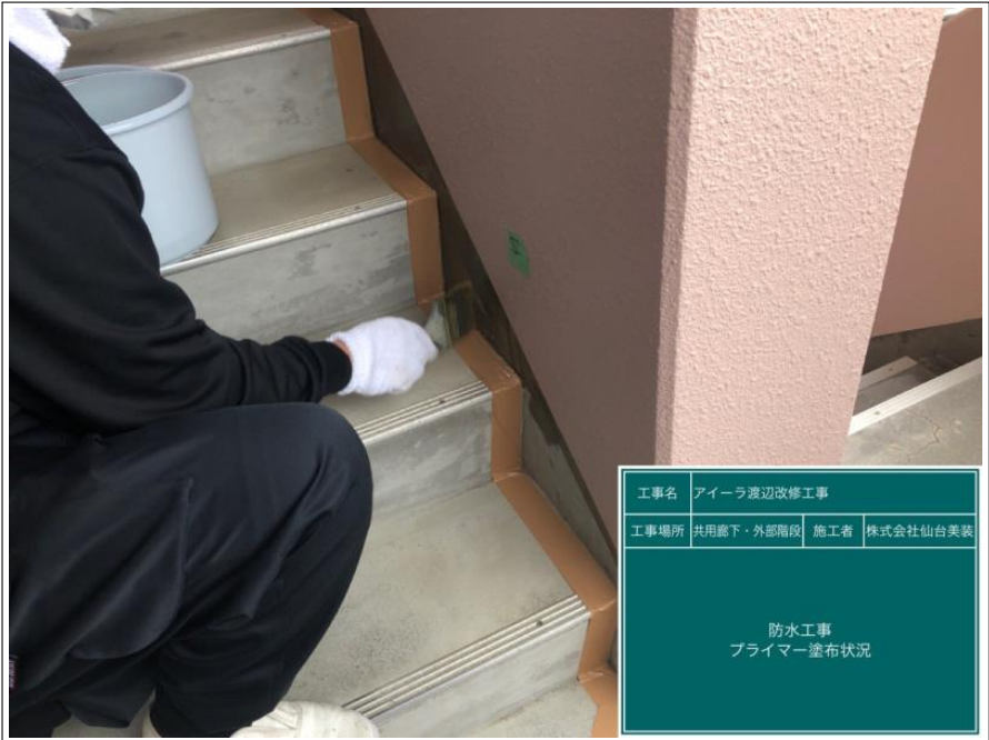
工事名 アイーラ渡辺改修工事 工事場所 共用廊下・外部階段 施工者 株式会社仙台美装 防水工事 下地処理
