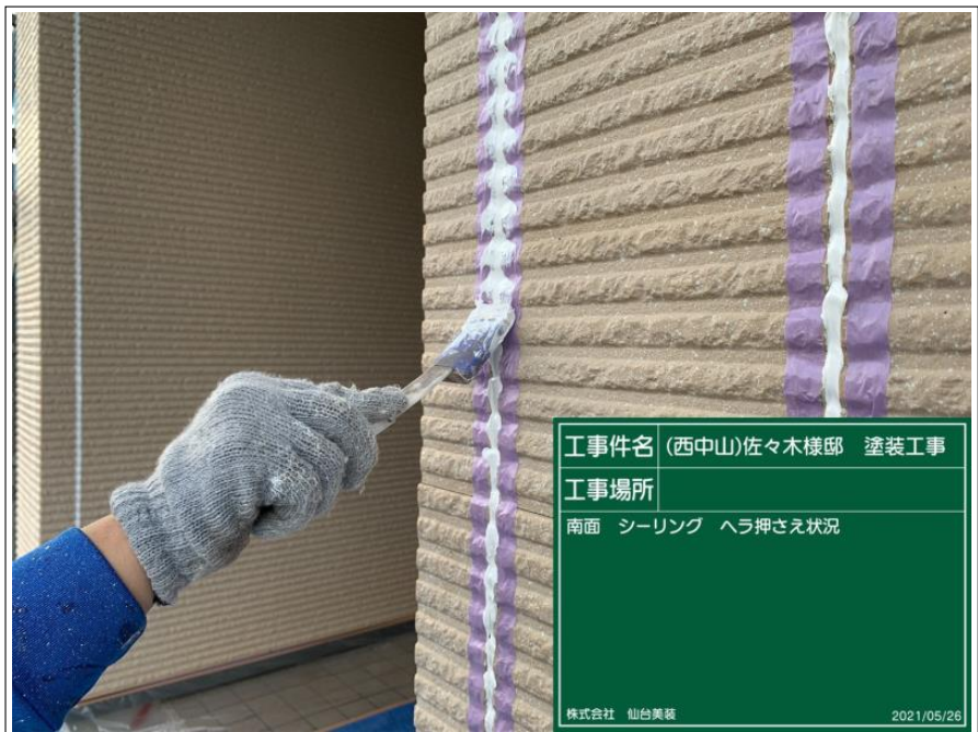
西中山 佐々木様邸 塗装工事 シーリング作業
