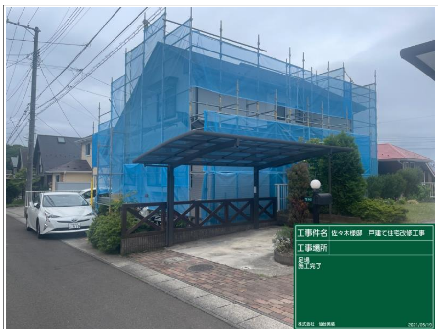
西中山 佐々木様邸 塗装工事 足場架設状況
