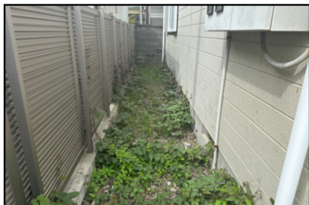
クレーンハウスA棟
