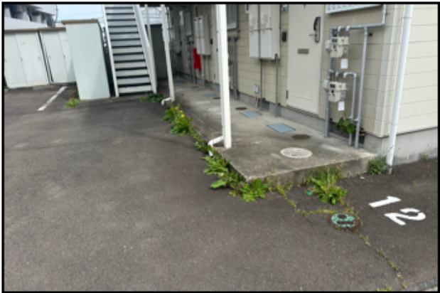
クレーンハウスB棟
