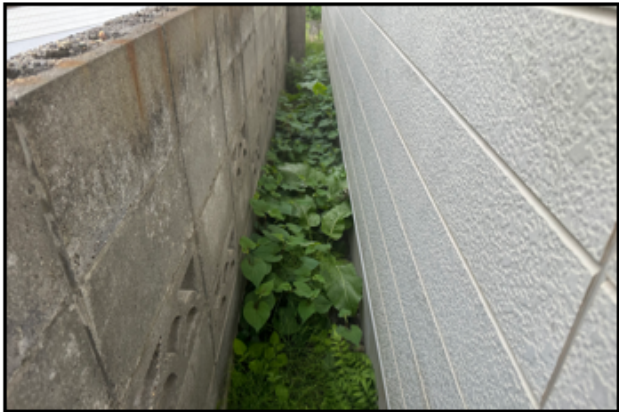
クレーンハウスB棟
