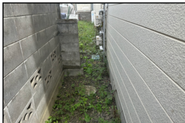
クレーンハウスA棟
