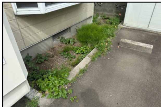
クレーンハウスA棟
