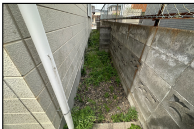
クレーンハウスA棟
