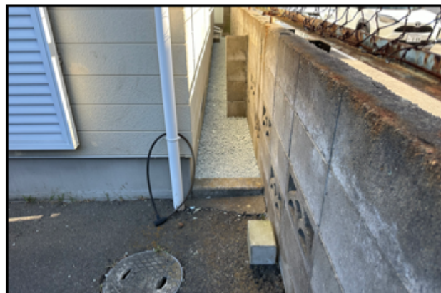
クレーンハウスB棟
