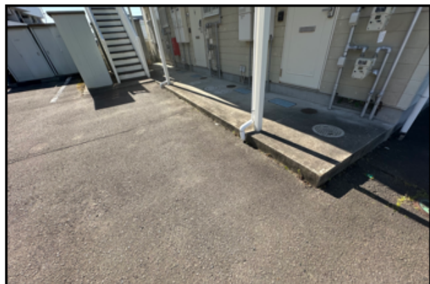
クレーンハウスB棟
