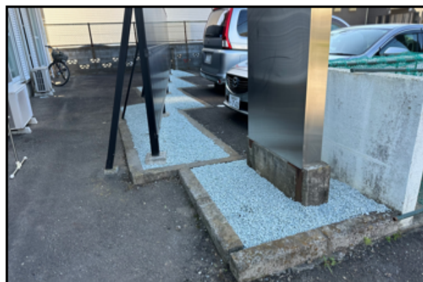
クレーンハウスB棟
