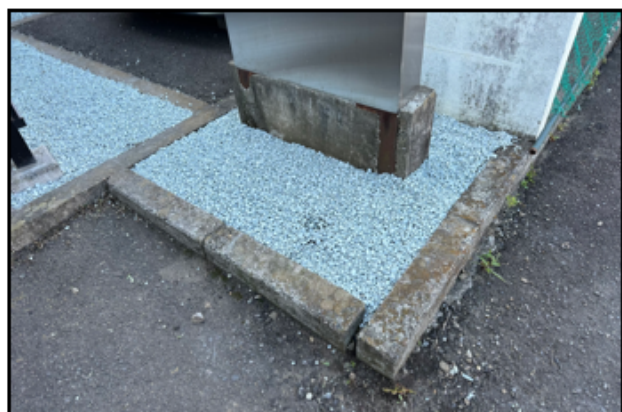
クレーンハウスB棟
