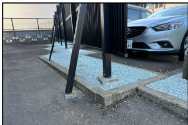
クレーンハウスB棟
