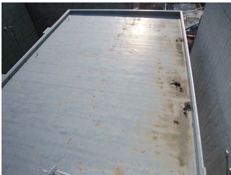
ベルメゾン MIYAZA 屋上等防水補修工事
