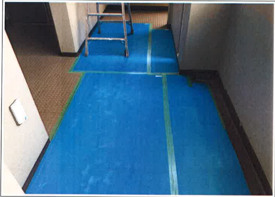
4階 屋上タラップ部床養生
