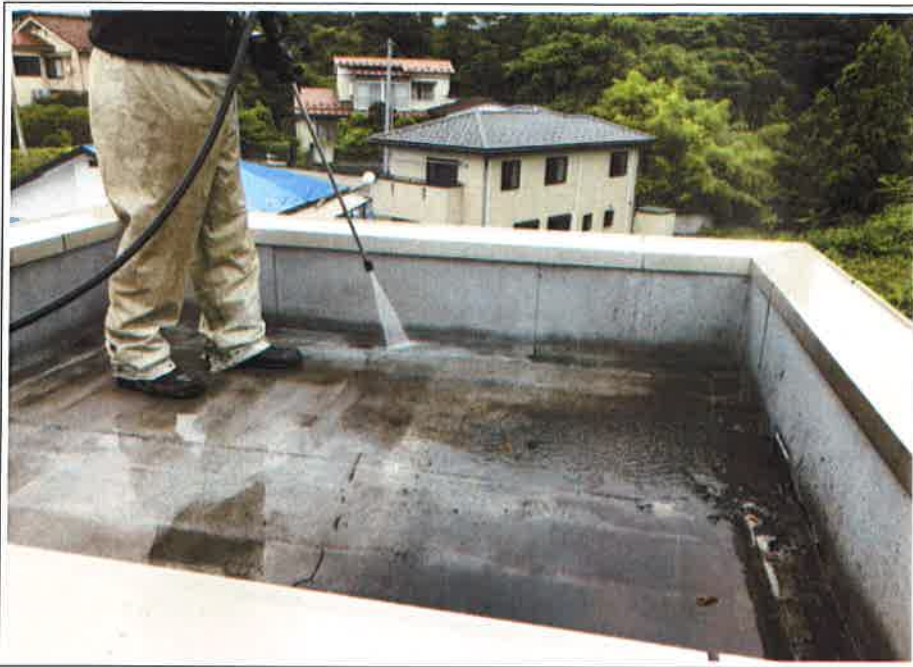
高压洗浄作業
