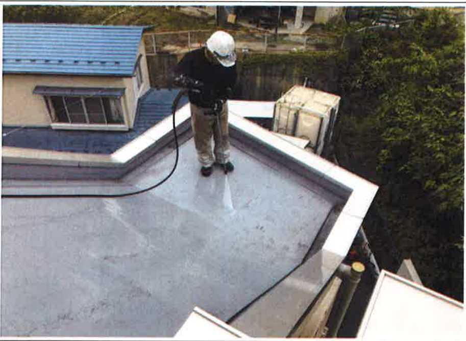
高压洗浄作業
