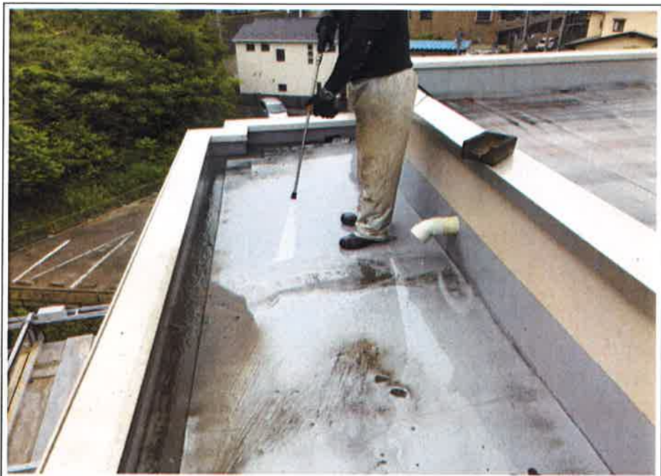
高压洗浄作業
