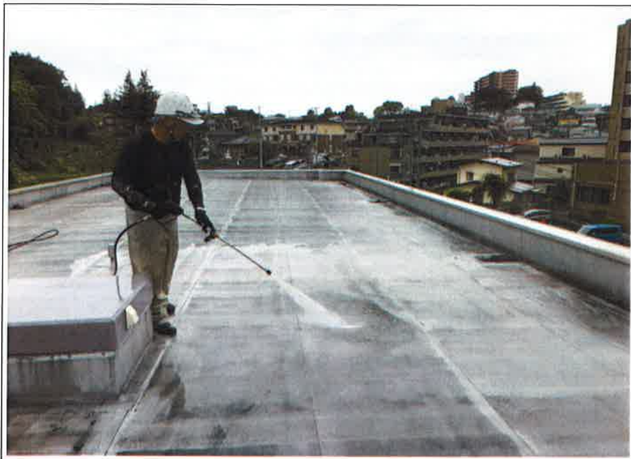
高压洗浄作業
