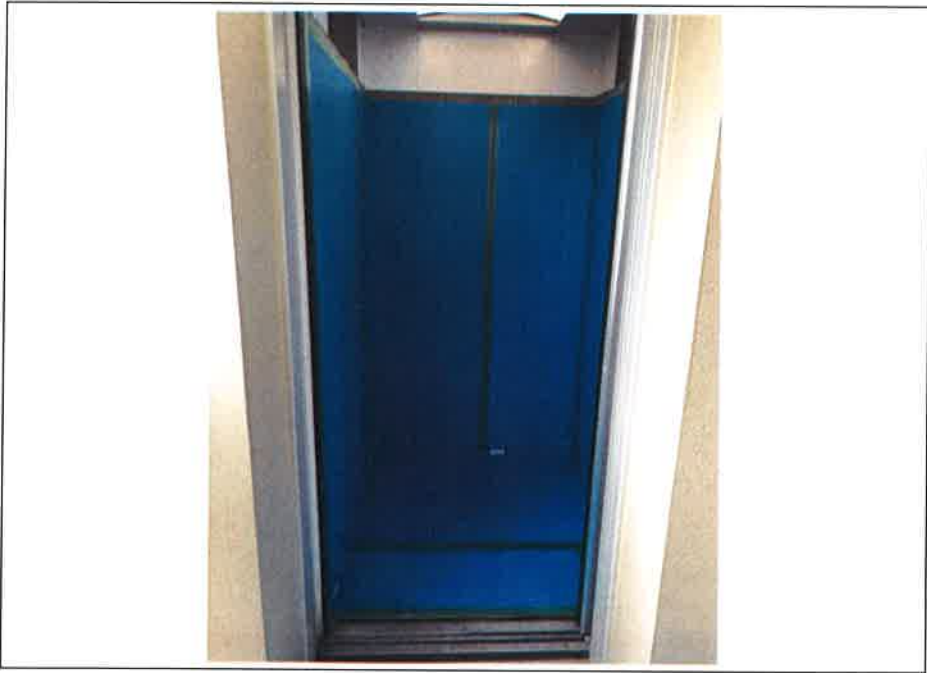
エレベーター養生
