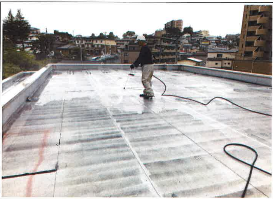
高压洗浄作業
