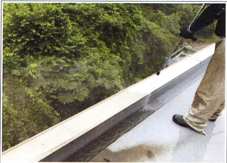
高压洗浄作業
