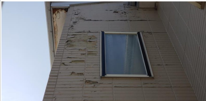
東面外壁修繕
