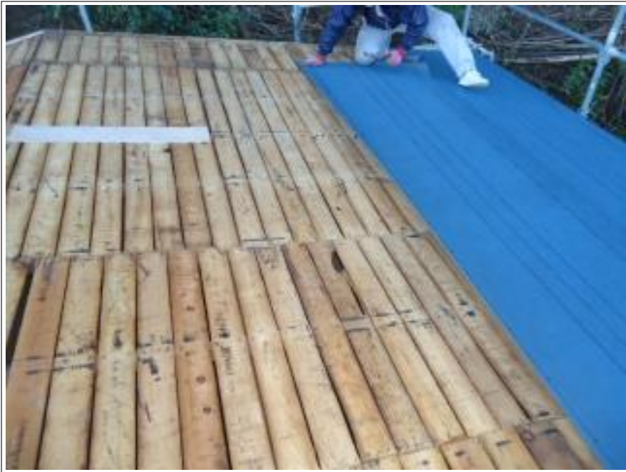
ルーフィングシート張り
