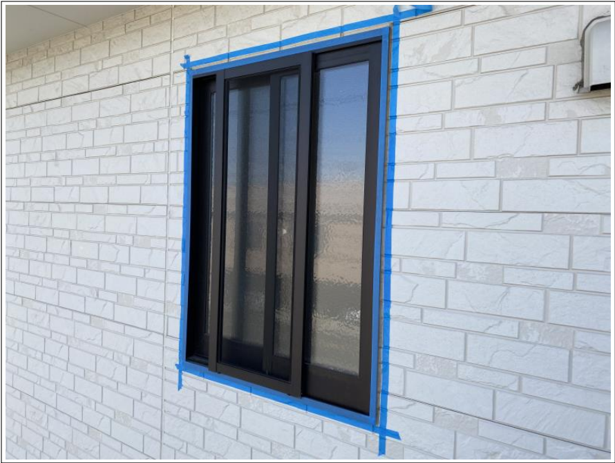
シーリング用養生
