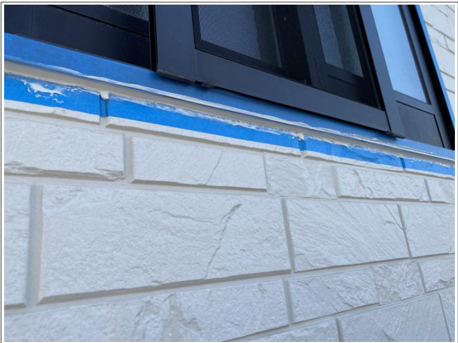
シーリング増し打ち工法
