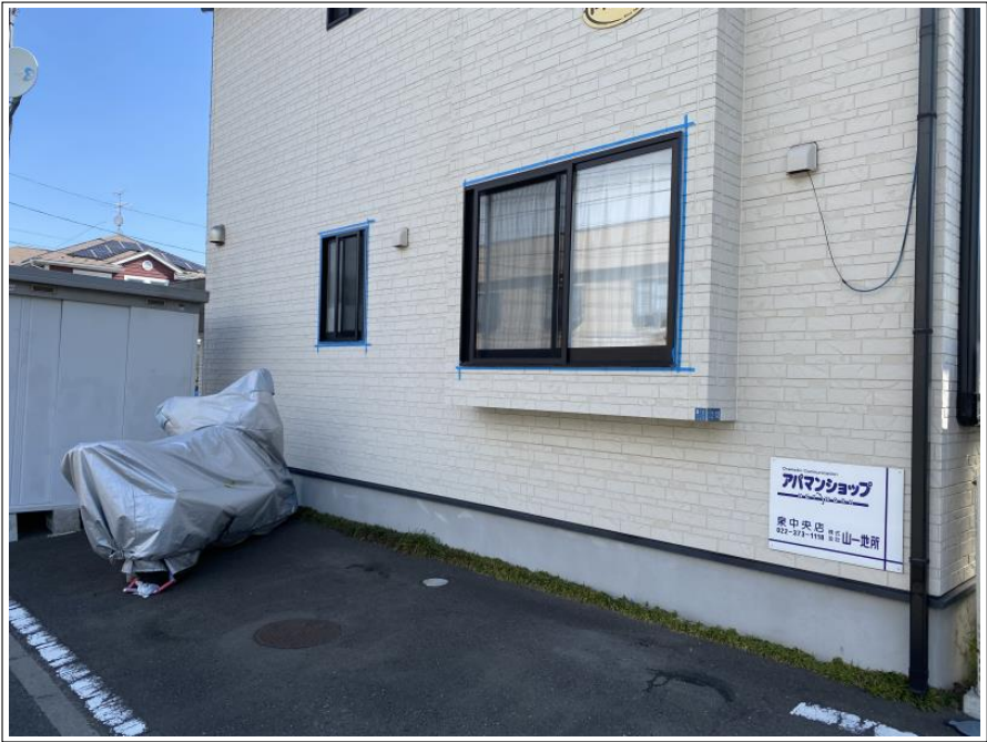
シーリング用養生
