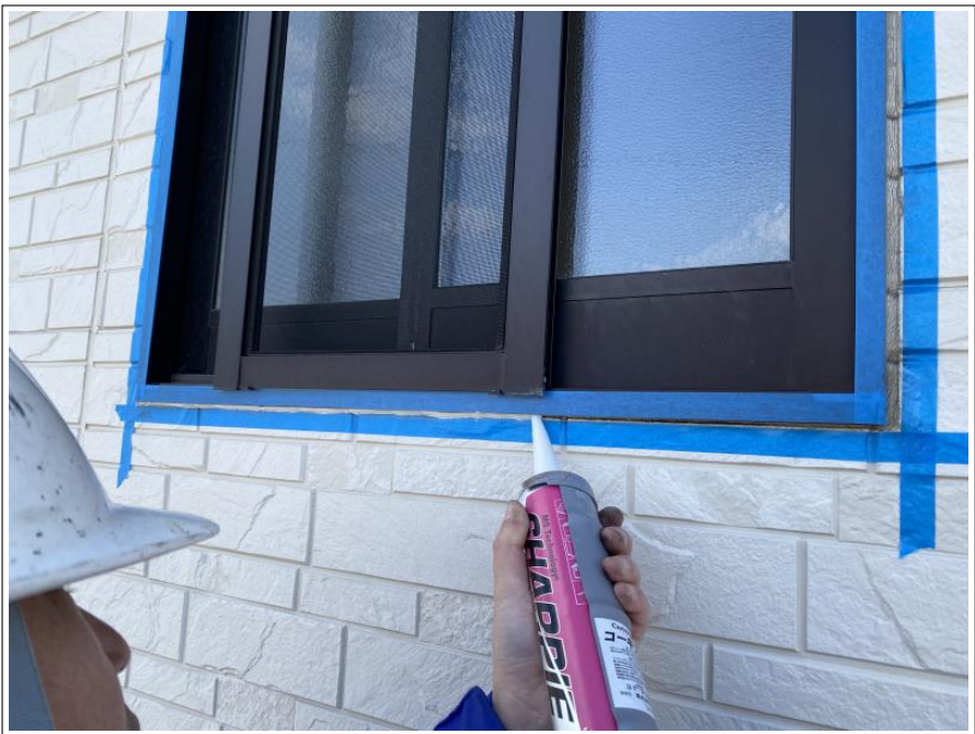
シーリング増し打ち工法
