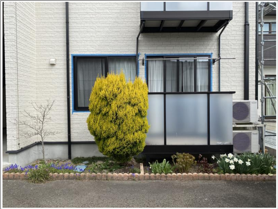
シーリング用養生
