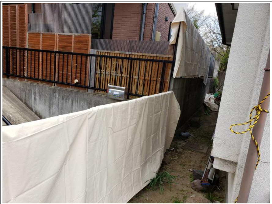
隣フェンス 飛散防止対策
