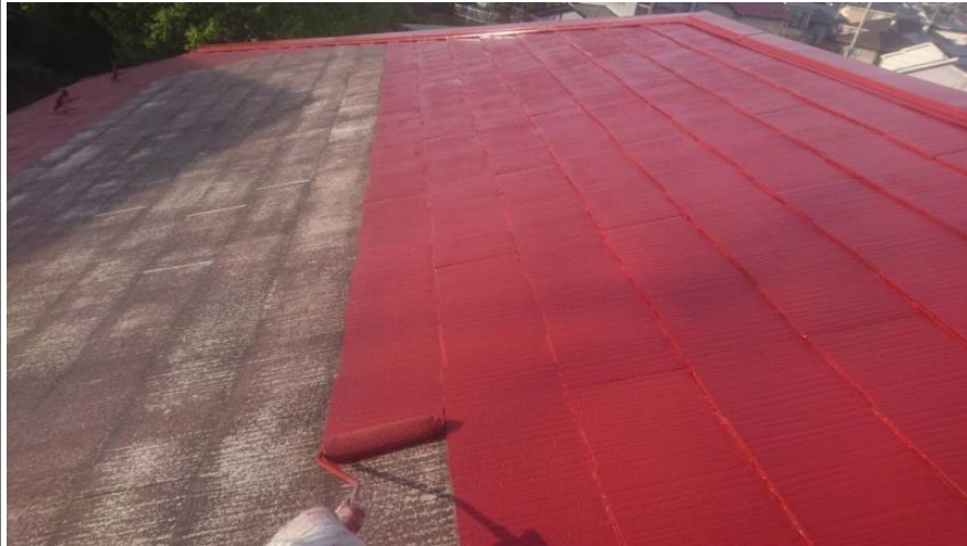
中塗り施工中
