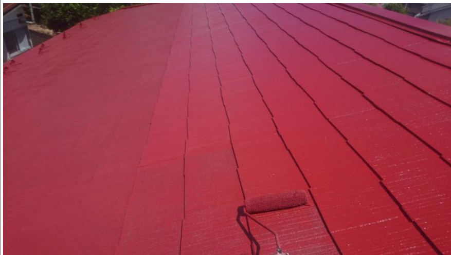
上塗り施工中
