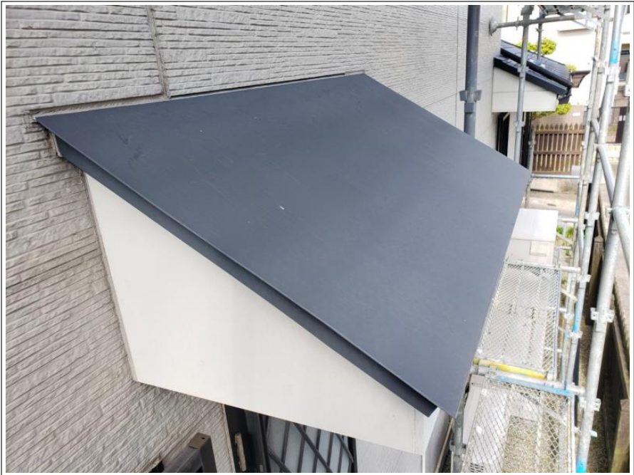
庇 施工前状況
