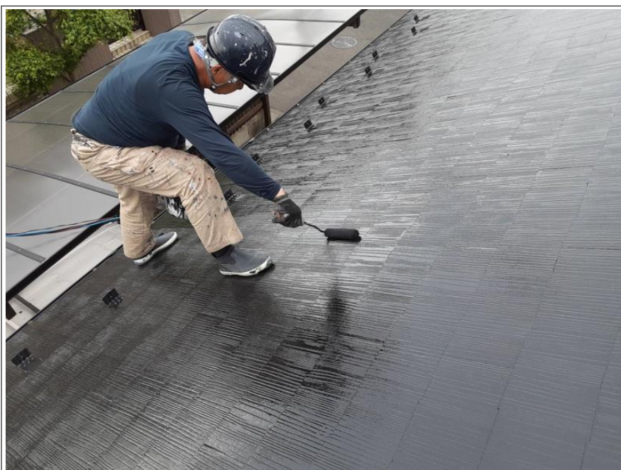
上塗り施工中
