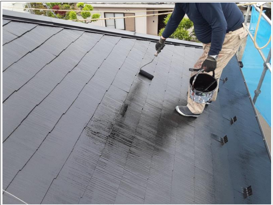
上塗り施工中
