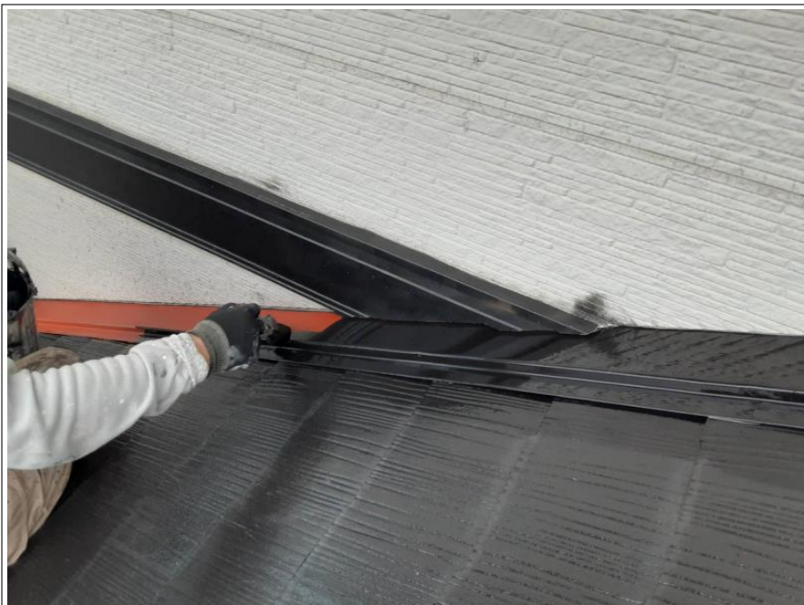
中塗り施工中
