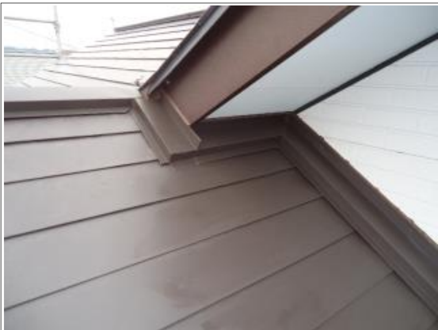
壁水切り 施工後
