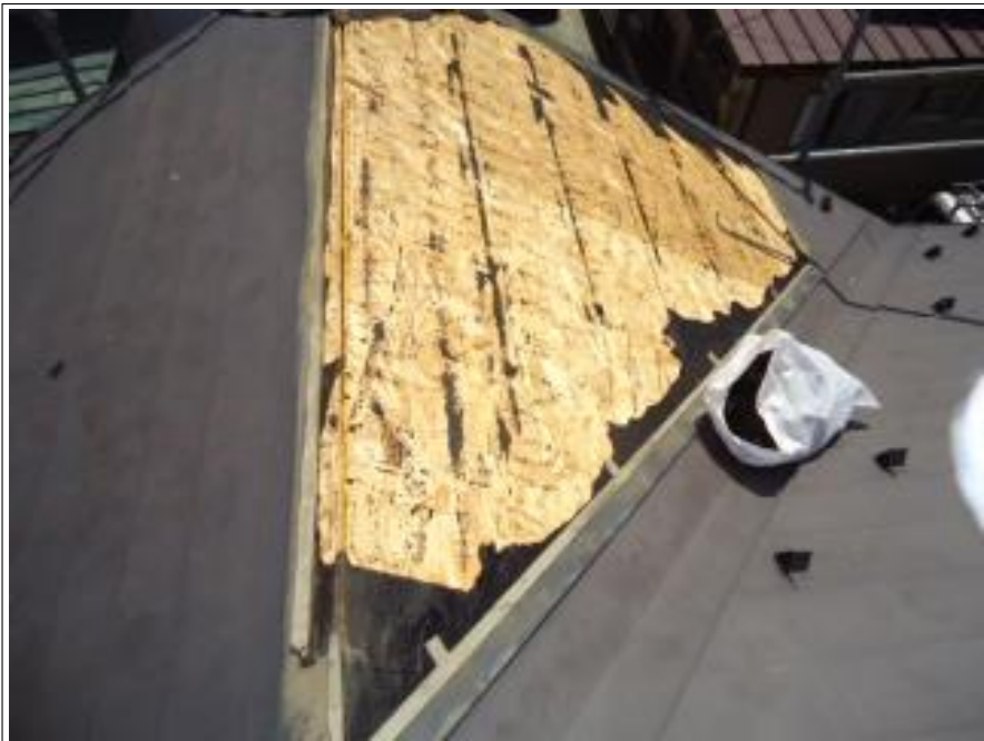
既存トタン撤去
