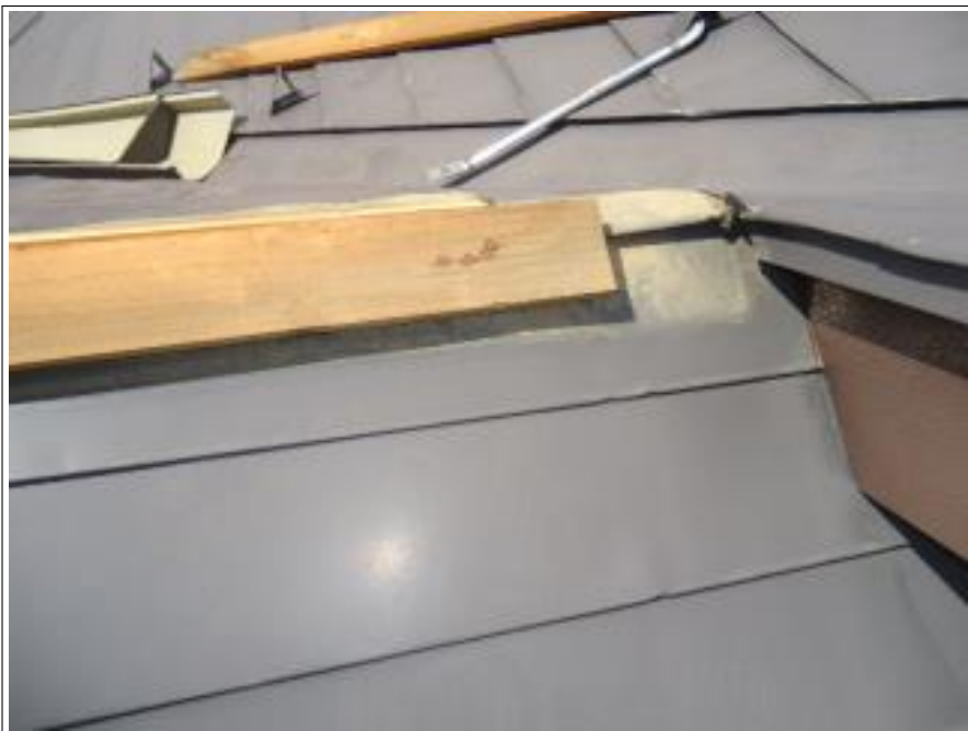
棟撤去 施工中
