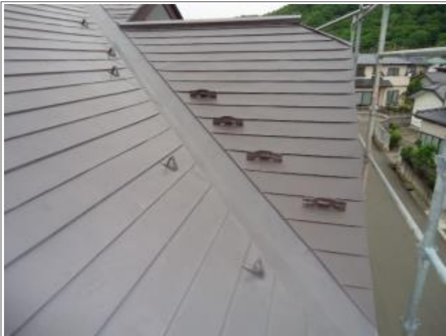
トタン屋根 施工後
