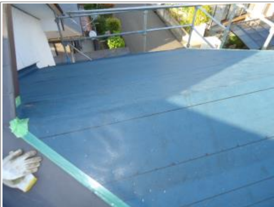
ゴムアスルーフィング貼り
