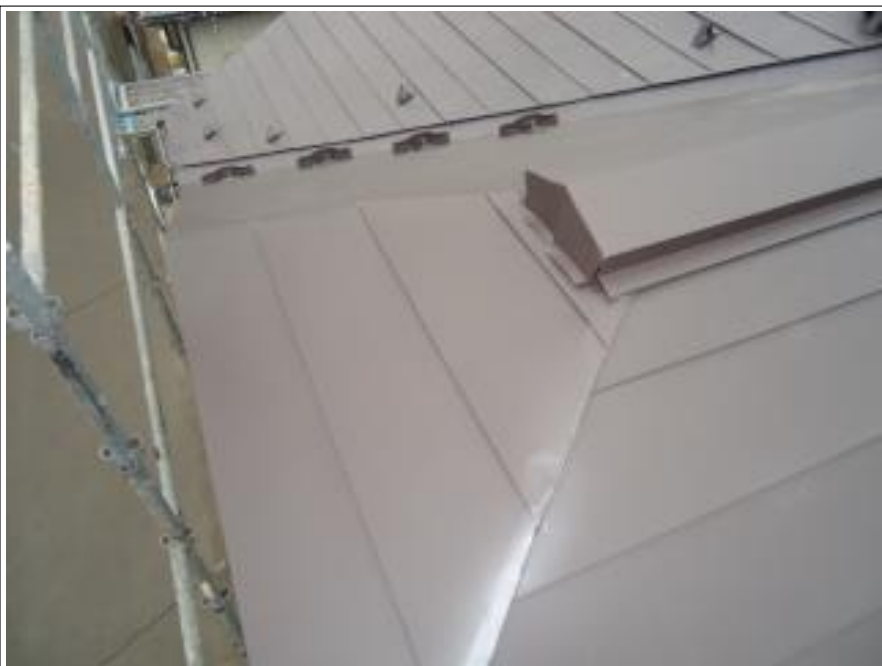
トタン屋根 施工後
