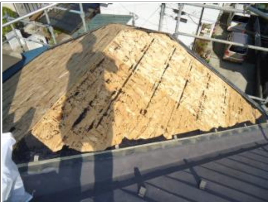
既存トタン撤去
