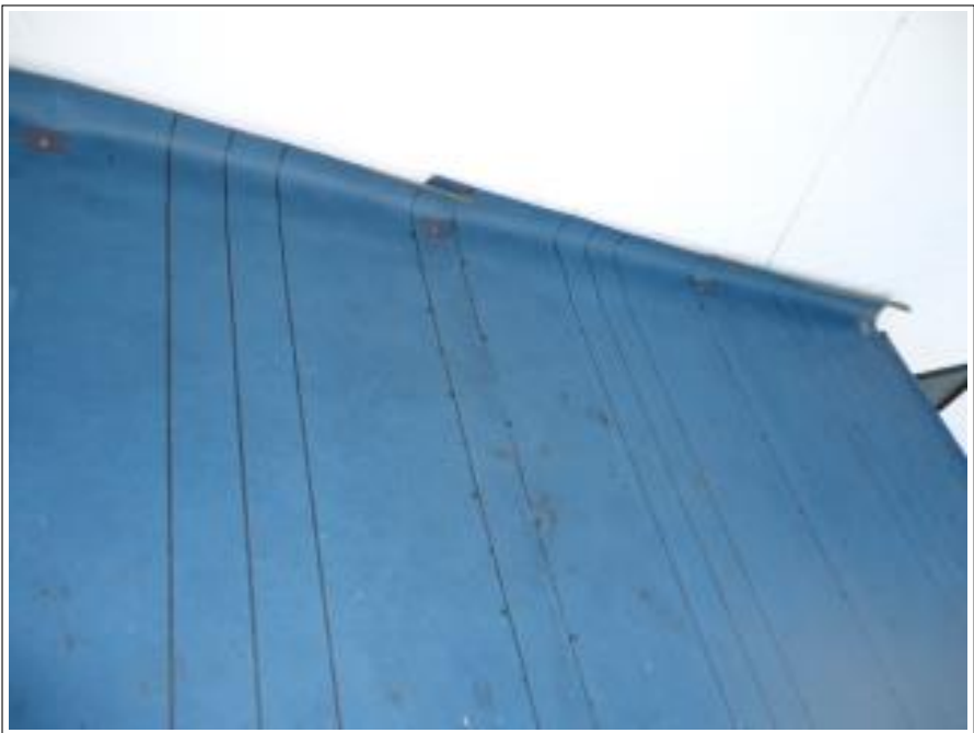
ゴムアスルーフィング貼り
