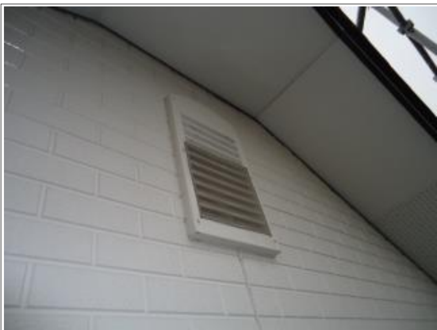
換気口網 取付け後
