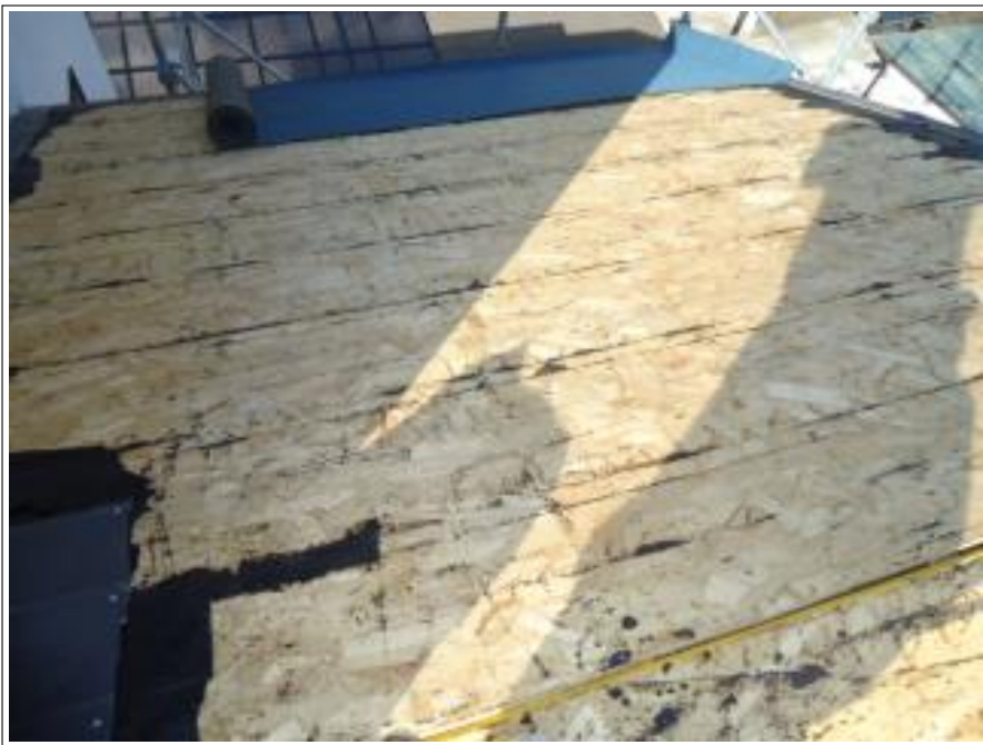
既存トタン撤去
