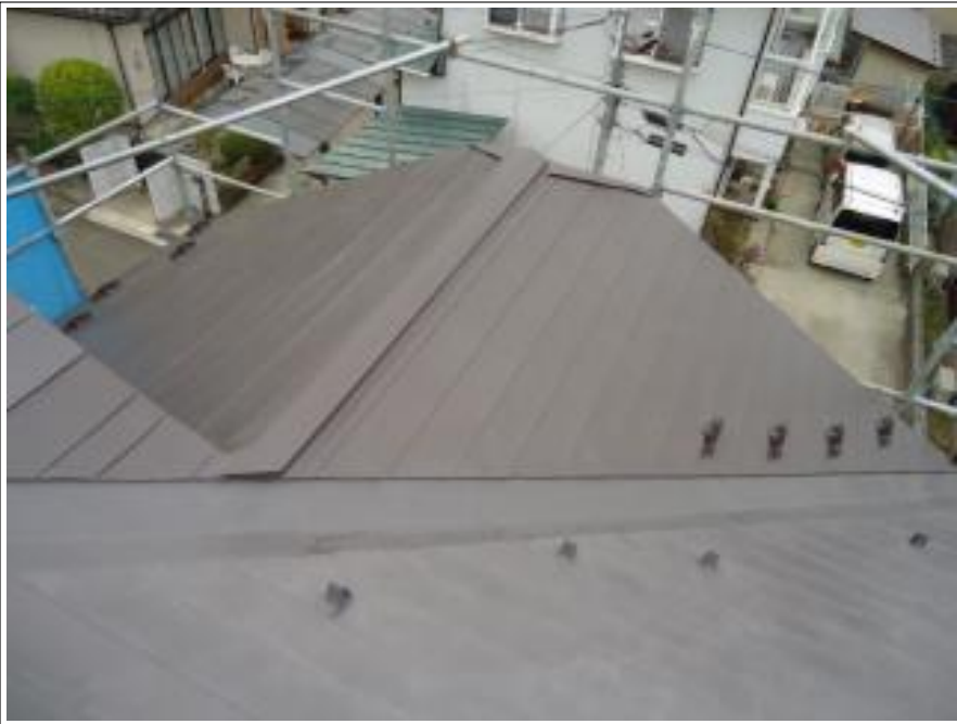
トタン屋根 施工後
