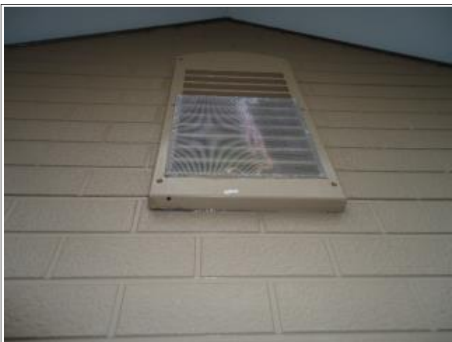
換気口網 取付け後
