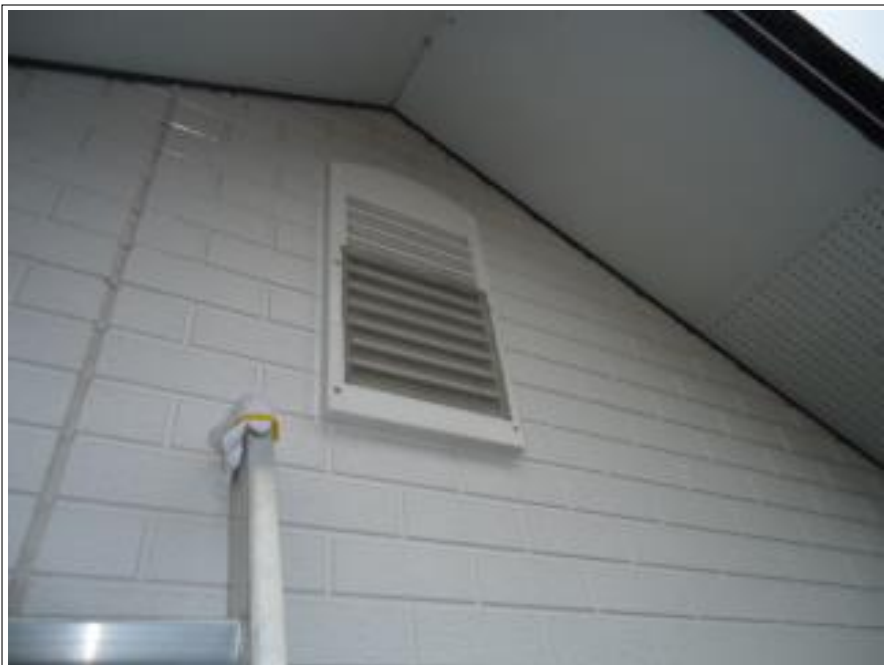
換気口網 取付け後
