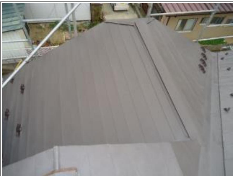
トタン屋根 施工後
