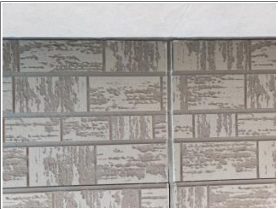
外壁シーリング
