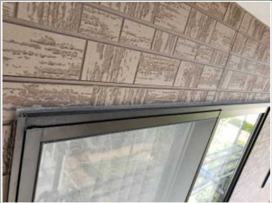
外壁シーリング
