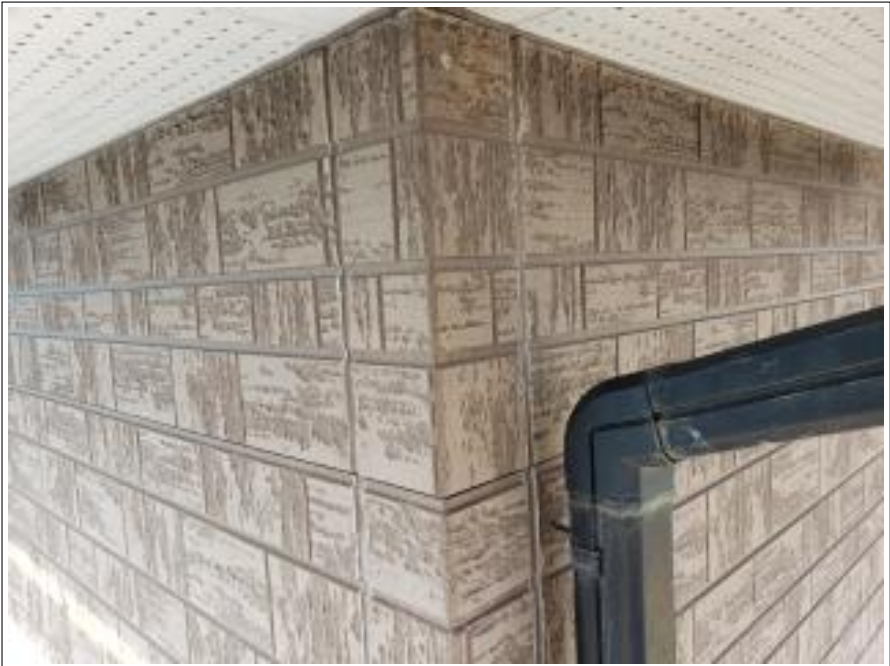
外壁シーリング
