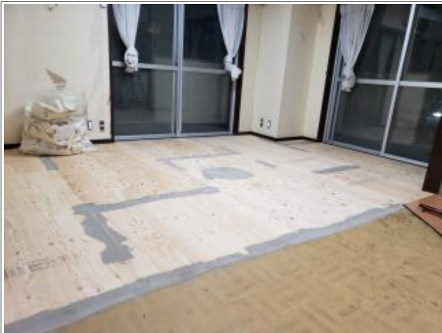
既存床撤去・コンパネ下地設置
