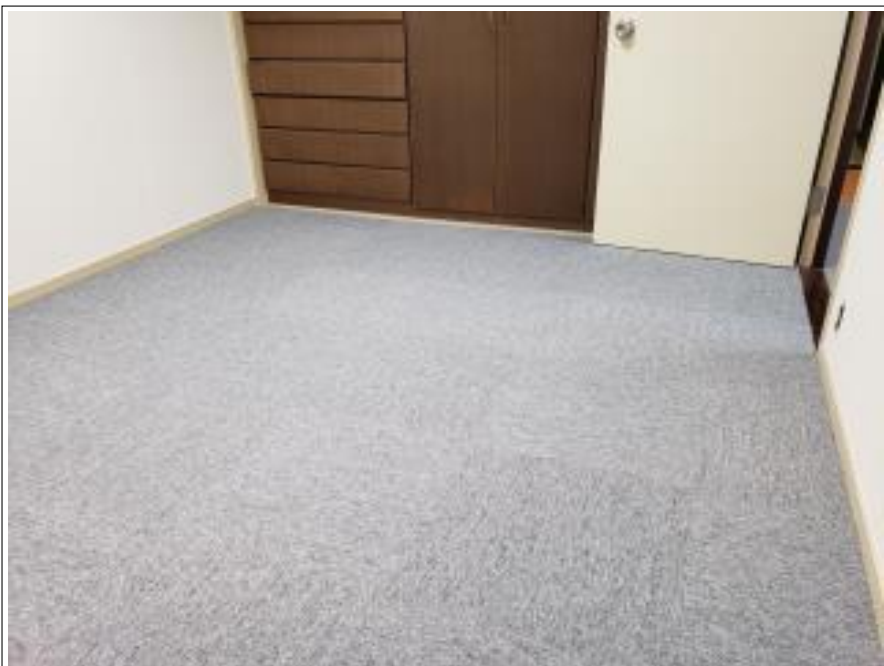
床面 タイルカーペット施工後
