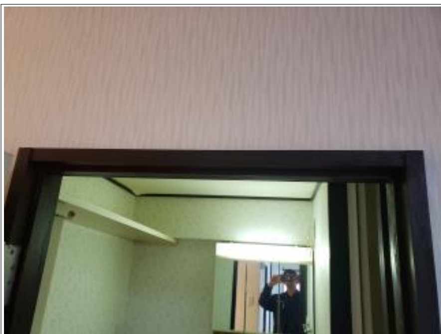
木部 補修塗装 施工後
