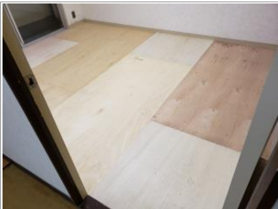
既存床撤去・コンパネ下地設置
