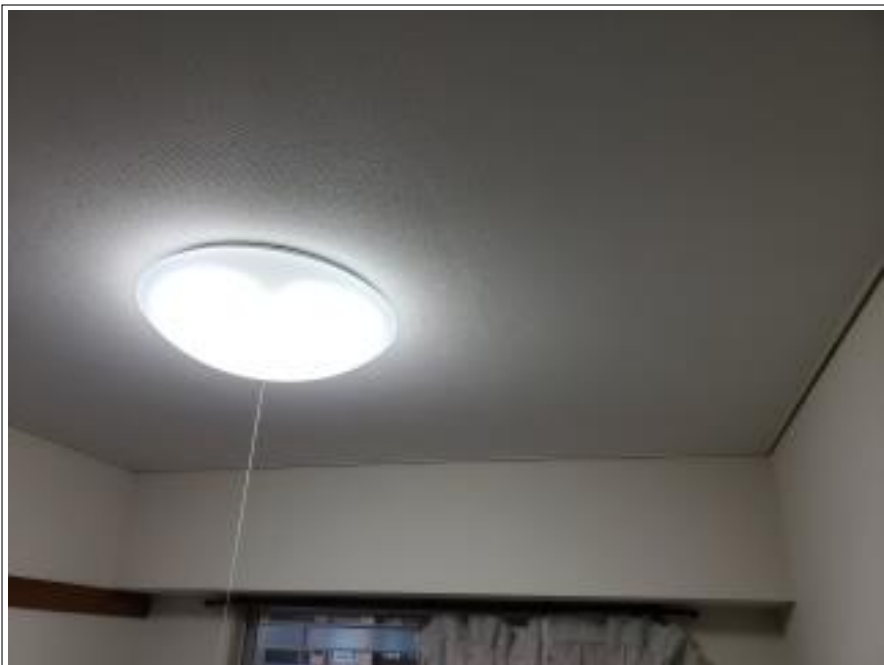
天井 クロス施工後
