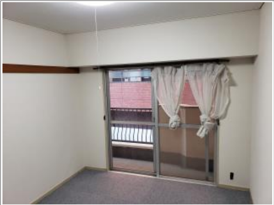
壁クロス 施工後
