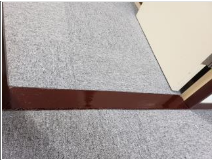
木部 補修塗装 施工後
