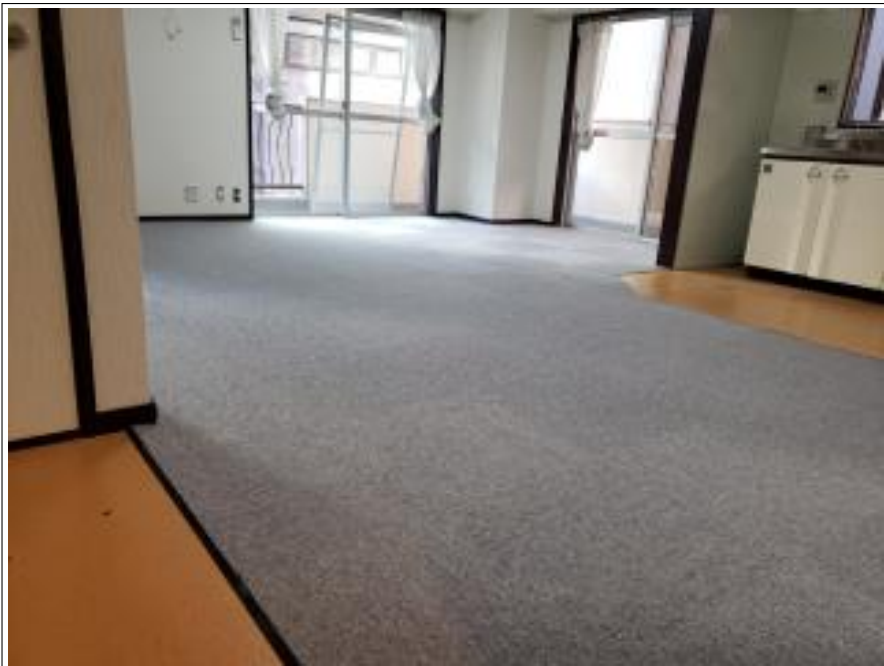
床面 タイルカーペット施工後
