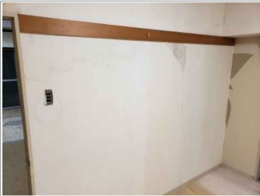
既存クロス 撤去
