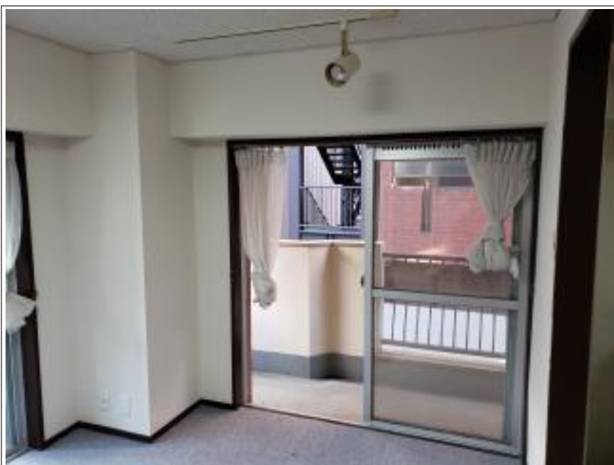
壁クロス 施工後
