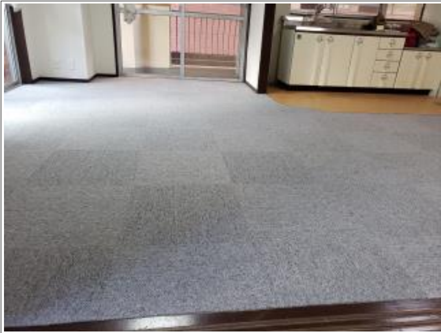
床面 タイルカーペット施工後
