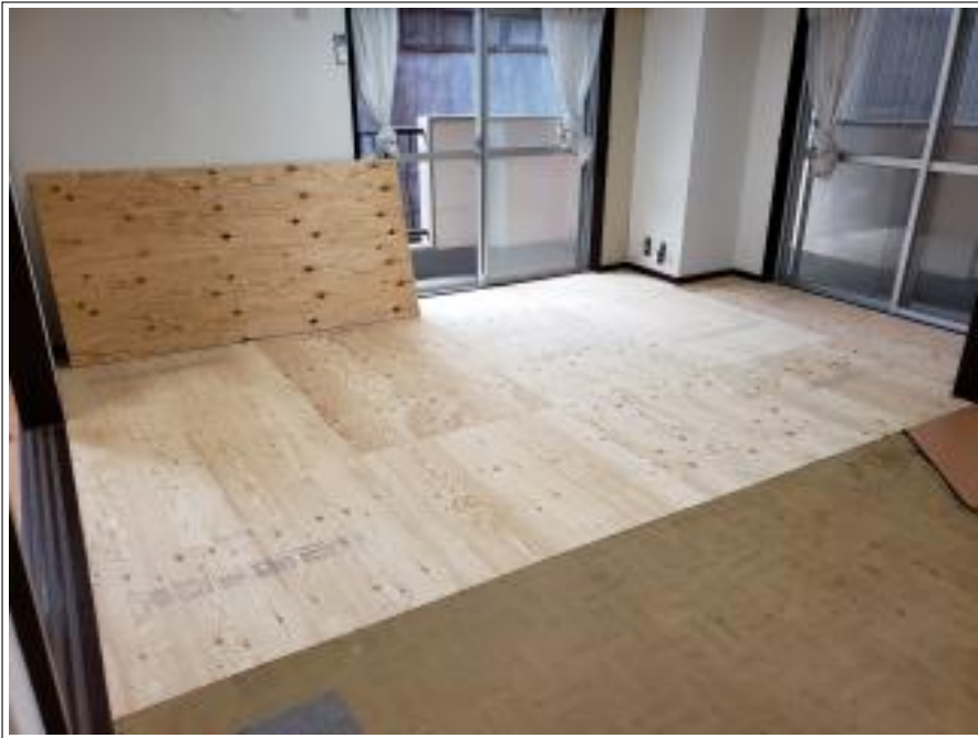
既存床撤去・コンパネ下地設置
