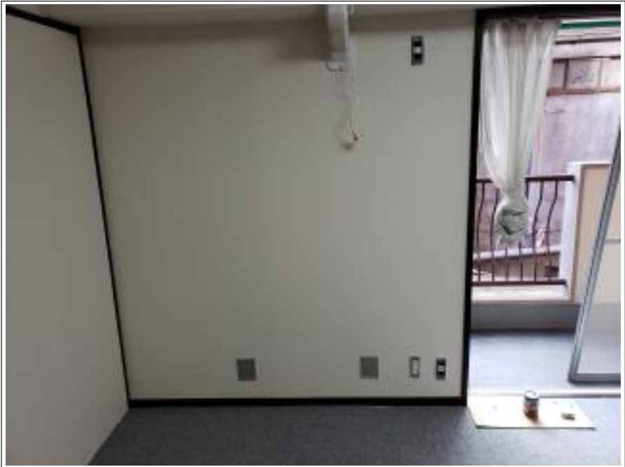
壁クロス 施工後
