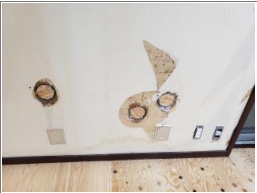
ボード部分 張替3箇所
