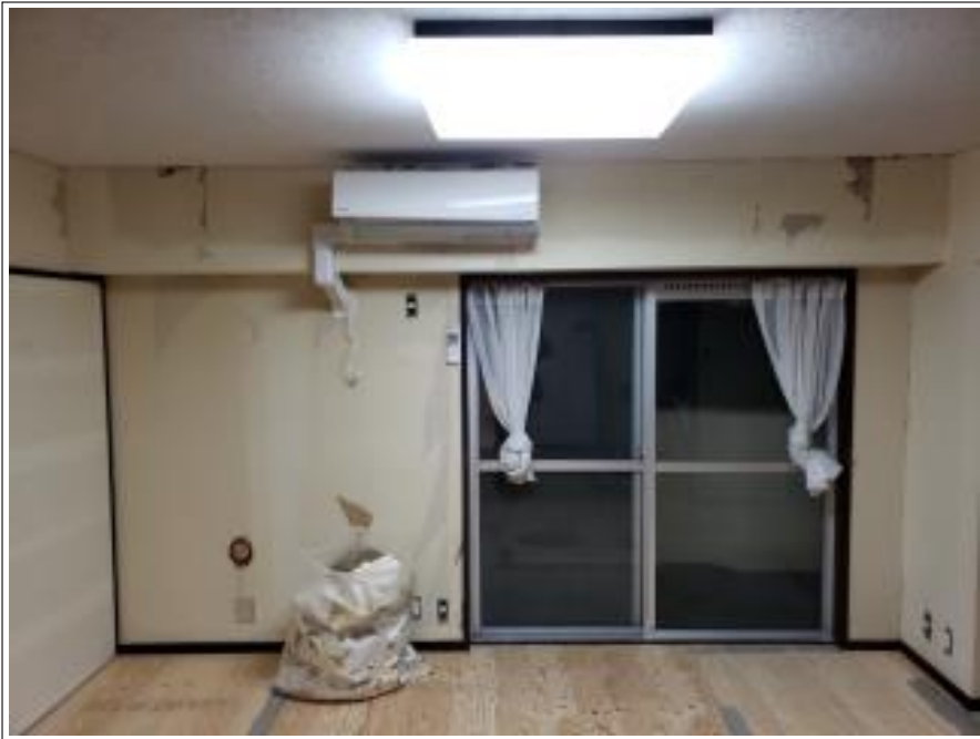
既存クロス 撤去
