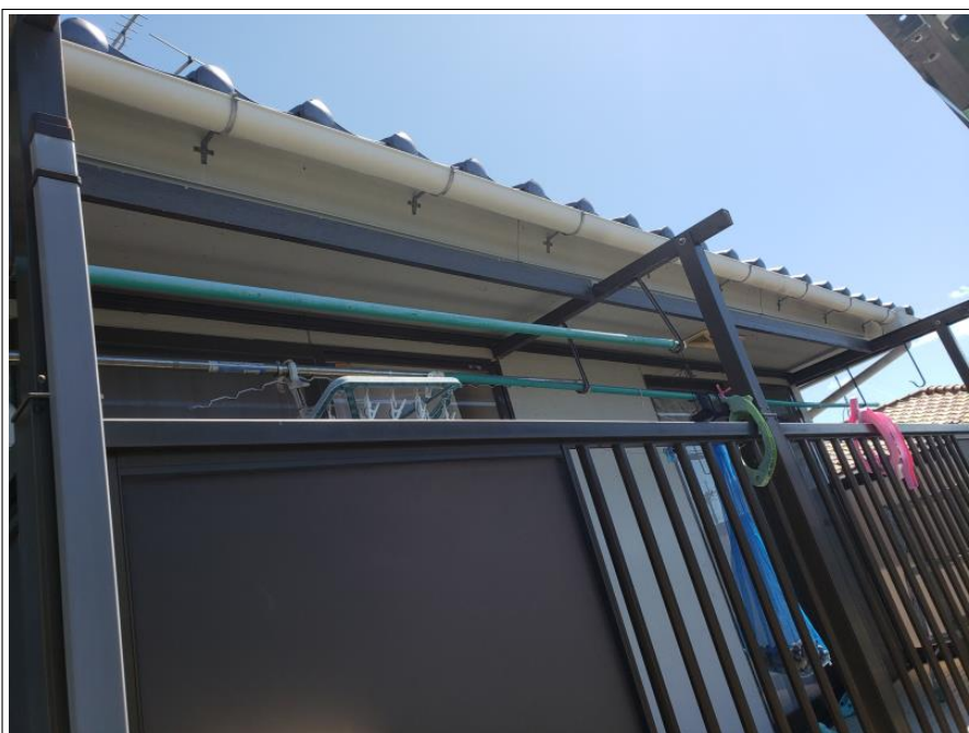
既存波板撤去
