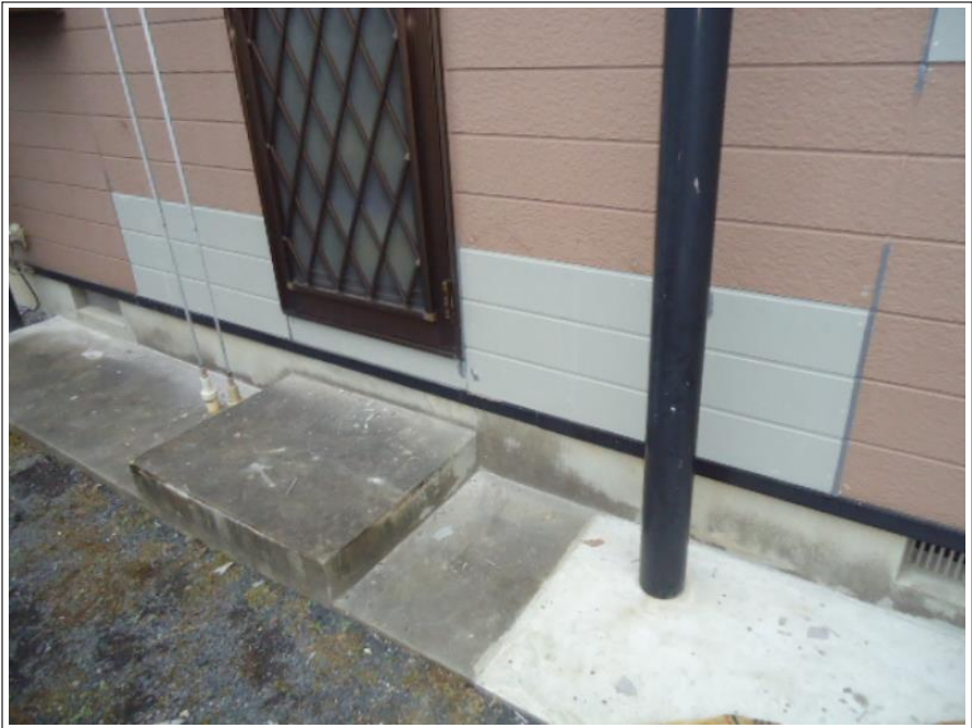
勝手口側外壁
