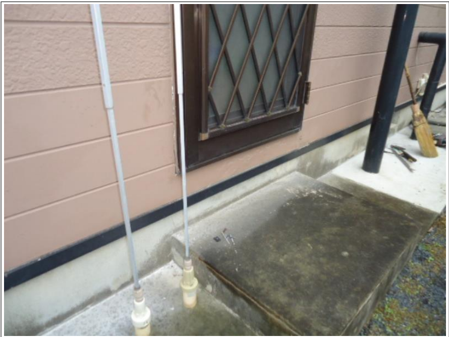
勝手口側外壁
