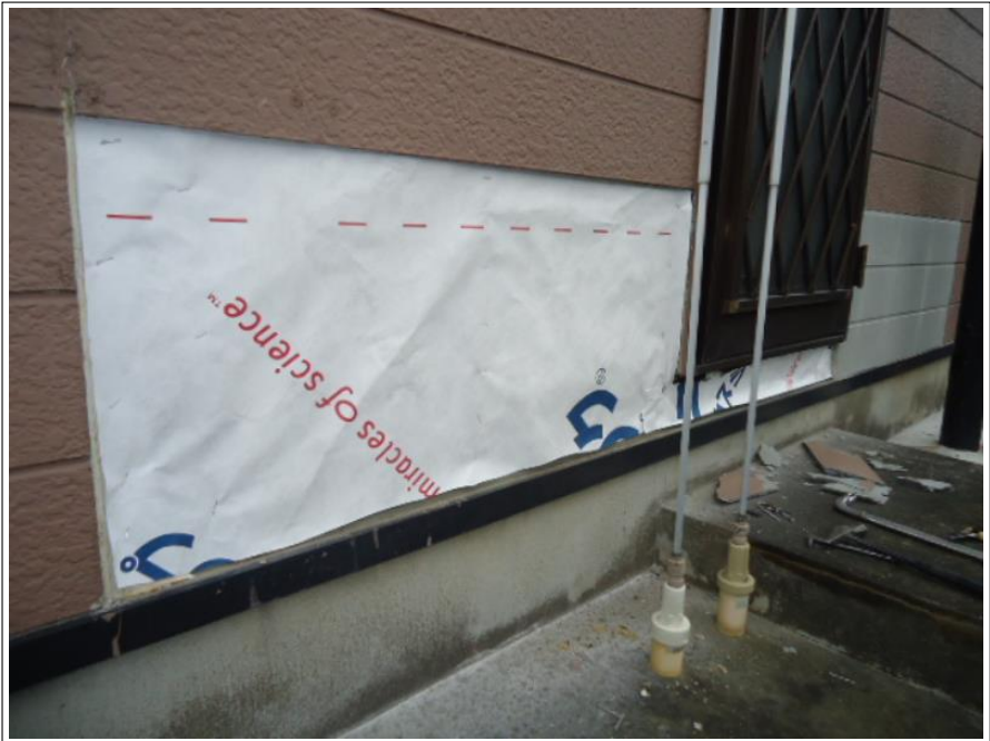
勝手口側外壁
