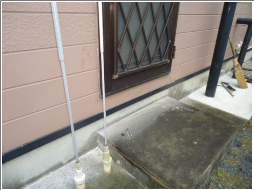
勝手口側外壁
