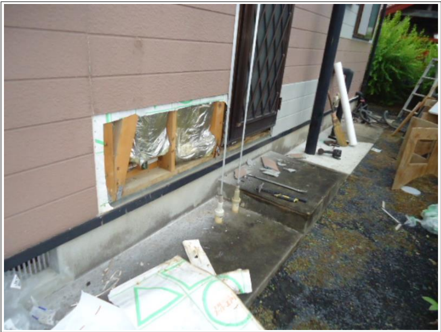
勝手口側外壁
