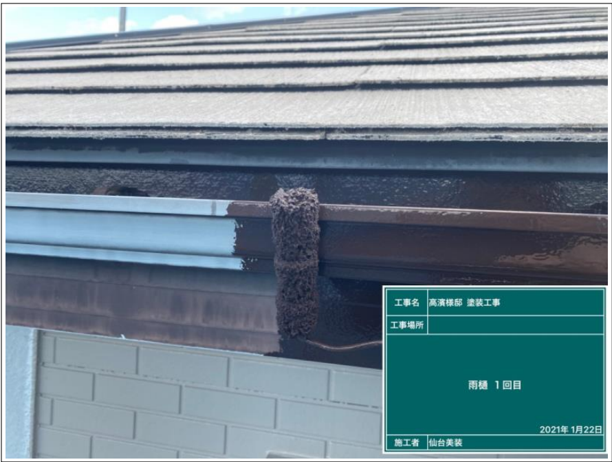
破風樋 下塗り
