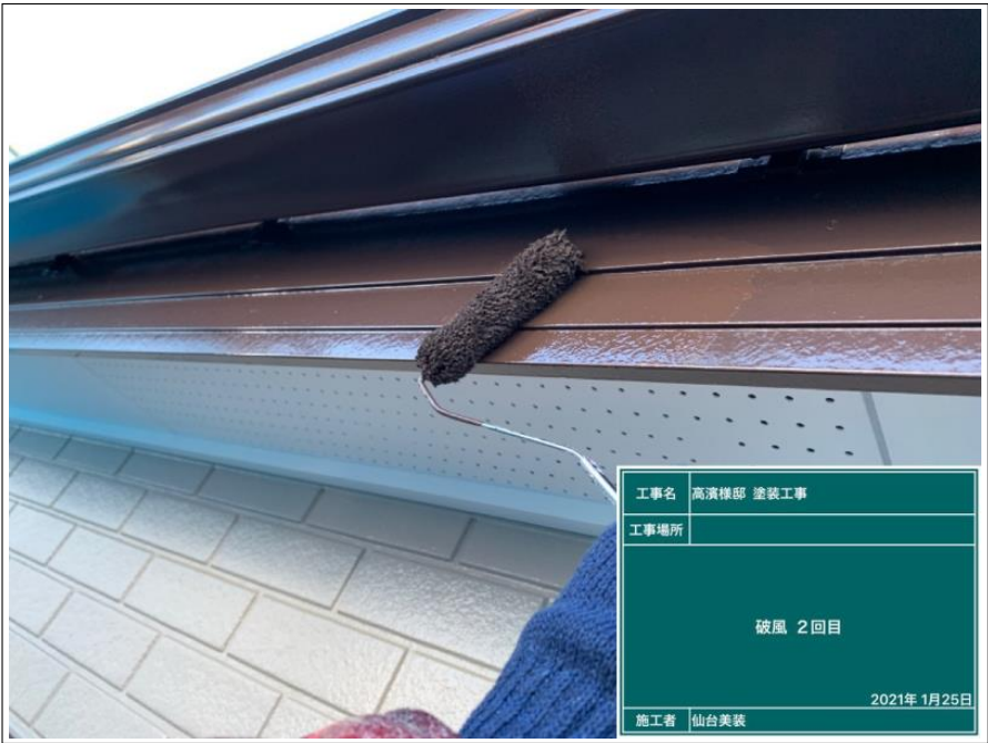
破風樋 上塗り
