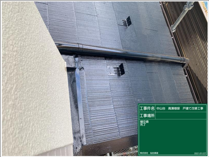
樋交換後 塗装完了
