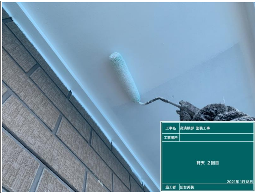
工事名 高濱様邸 塗装工事 工事場所 軒天 1回目 2021年 1月18日 施工者 仙台美装
