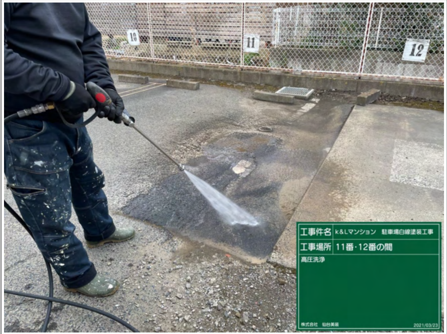
泥 高圧洗浄除去
